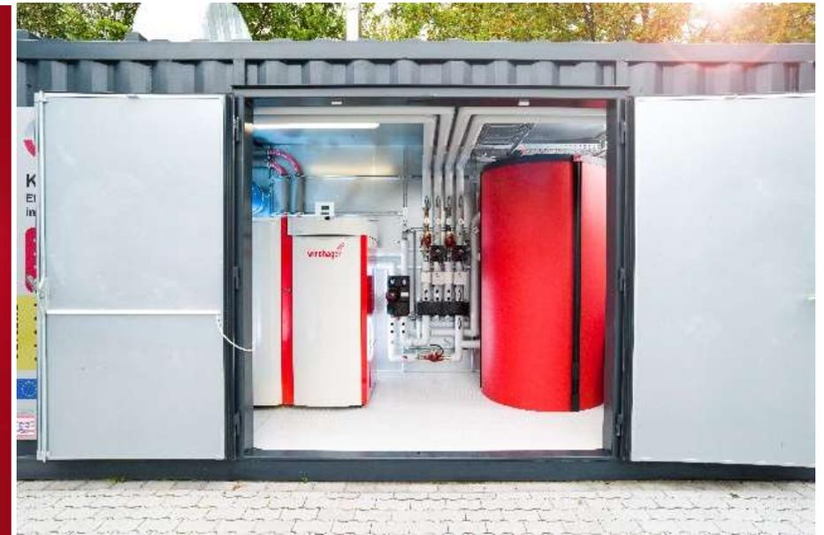
**Angewandte Querschnittstechnologie: Integriertes Wärmerückgewinnungssystem innerhalb der Airbox und systemische Einbindung einer Biomasse-Heizanlage, inkl. Biomassespeicher**
